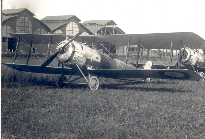
Les avions devant les halles de montage construites en 1917, et aujourd'hui protégées au titre des Monuments Historiques.
